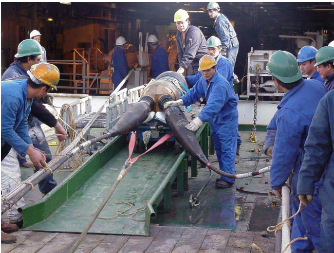
Рис. 8. Рабочие готовятся к прокладке кабеля
